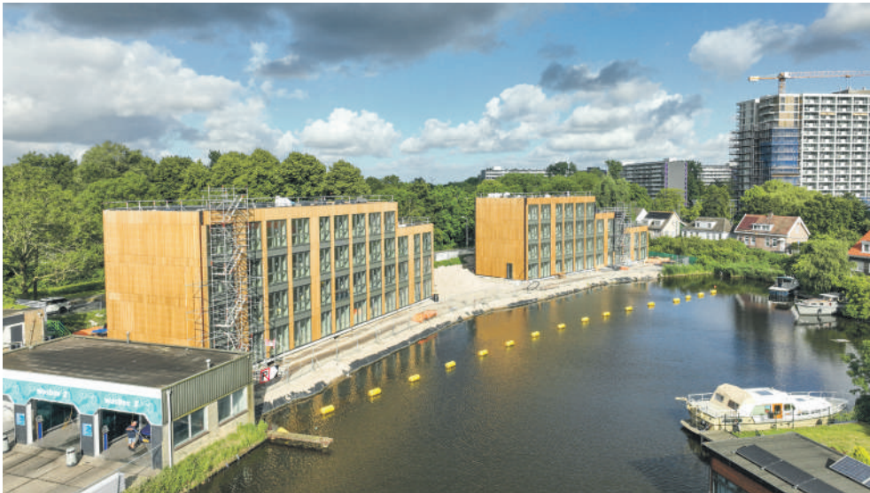
Appelweg in aanbouw
