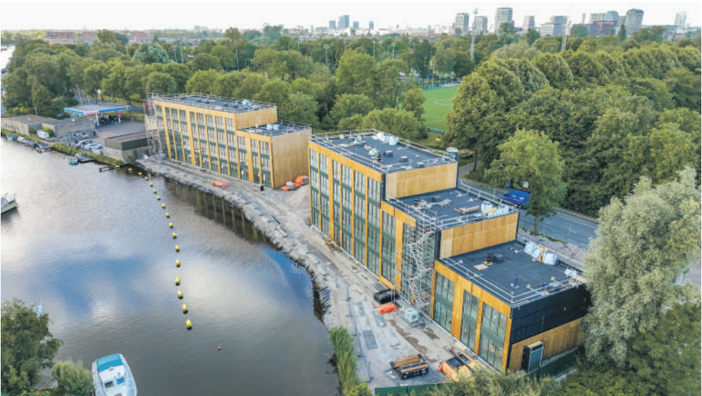
Appelweg in aanbouw
