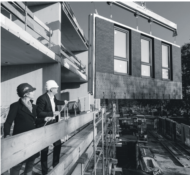
Bouwgroep Dijkstra Draisma gevelmontage op locatie.
