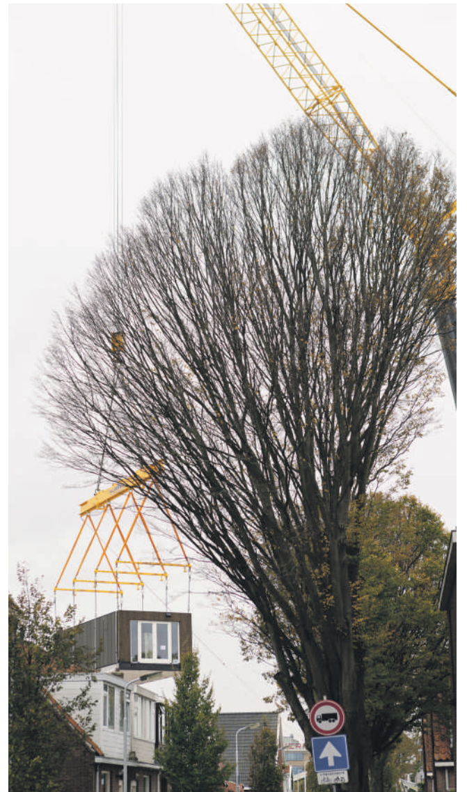
Module van Homes Factory door de lucht
