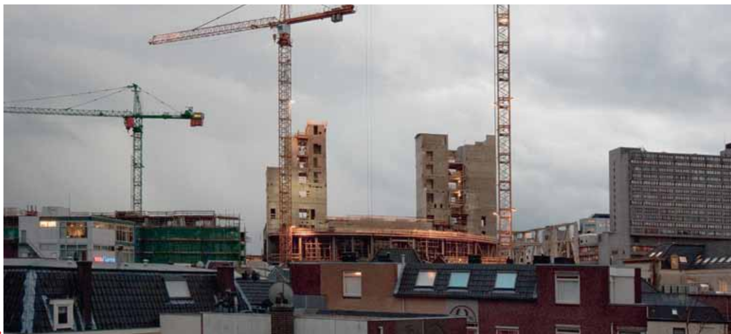
1 De bouw van beide liftkokers, gezien vanaf het Smakkelaarsveld in 2011 2 Liftschachten en trappenhuizen steken als kasteeltorens boven de daken van de oude stad uit.
