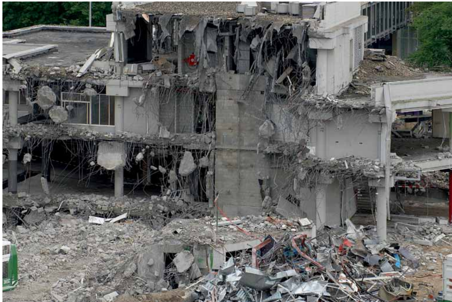
1 De 'ruïne' van Vredenburg, het begin van de sloopwerkzaamheden in 2008
